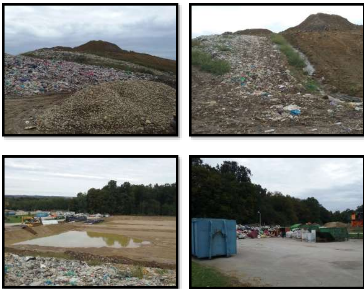
Slika 2.1.-2. Postojeće stanje lokacije na dan 25.09.2015.
